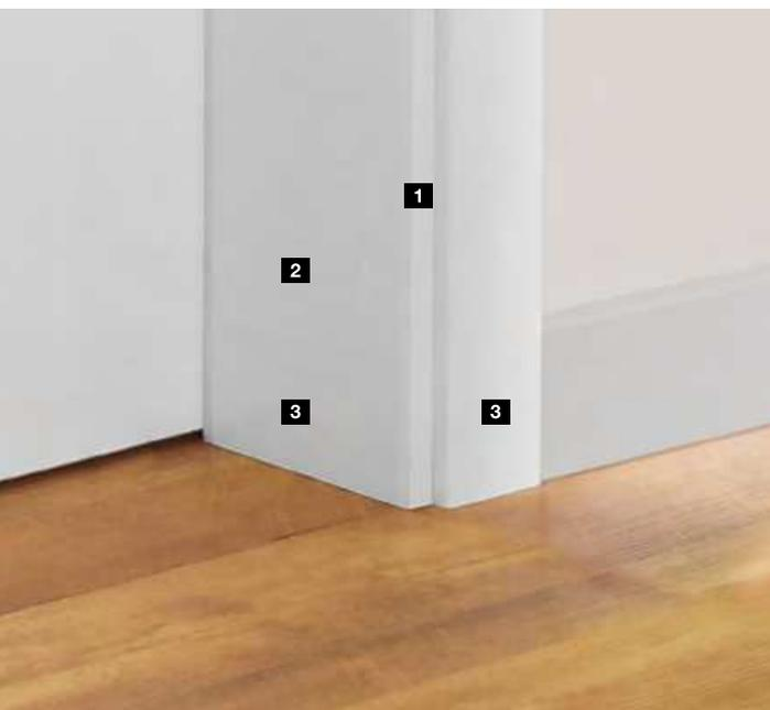
**HOCHWERTIGE HOLZZARGE.** Der form-schöne Kantenradius von 3 mm **1** überzeugt mit einer modernen rechteckigen Ansicht und einem nahtlosen Kantenabschluss. Das 25 mm starke Futterbrett **2** sorgt für eine hohe Formstabilität und durch die hochwertige Duradecor Oberfläche **3** ist die Zarge zudem besonders stoß- und kratzfest.
