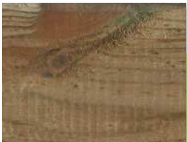
Raue Stellen auf der Oberfläche
